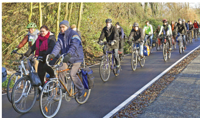
Ein erster Teilabschnitt des RS1 ist im November in Mülheim offiziell eröffnet worden. Rechts der zwei Meter breite Fußweg, links der vier Meter breite asphaltierte Radweg. Foto: RVR/Tom Schulte
