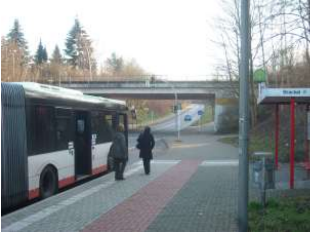
Das neue Blindenleitsystem an der Bushaltestelle führt leider nicht zum S-Bahnsteig
