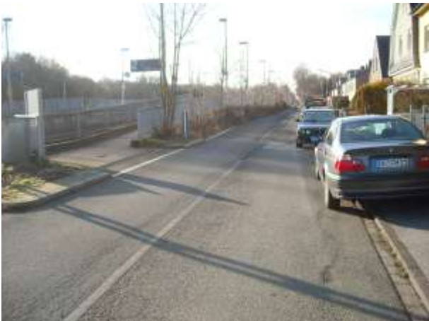
Zugang vom Gehweg zum Bahnsteig für Kinder schwer einsehbar
