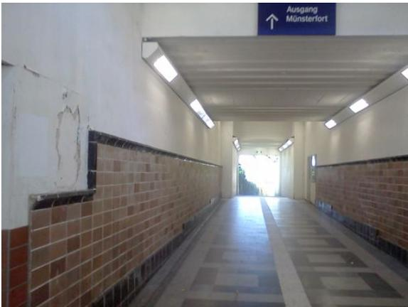
*Die Unterführung – an einigen Stellen ist der Putz abgeblättert*
