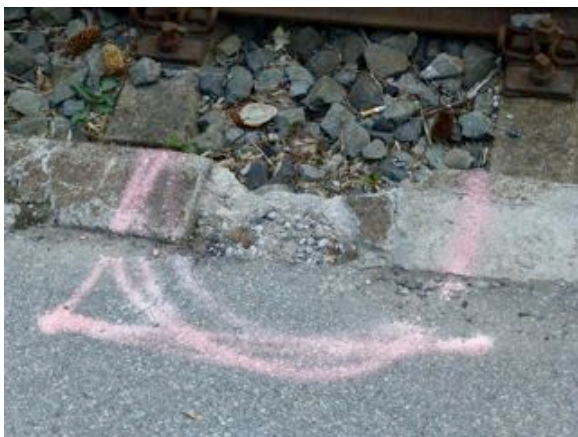
Stolperstellen gefährden wartende Fahrgäste
