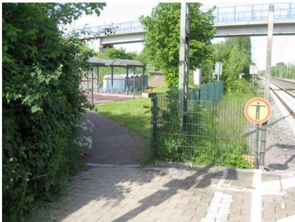
Nicht zufriedenstellend: Der Zugang zum Bahnsteig in Richtung Dortmund
