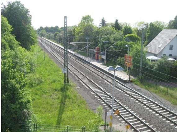
Der Bahnsteig in Richtung Dortmund von der Fußgängerbrücke aus
