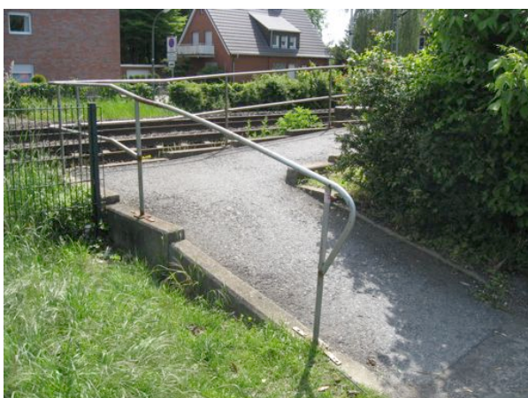
Zum Teil steile und enge Zugangswege
