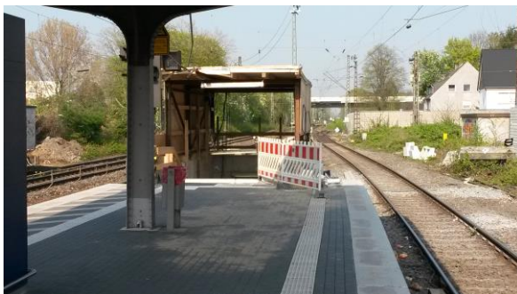
Erneuerte Bahnsteigpflasterung und bauliche Vorarbeiten für die Barrierefreiheit
