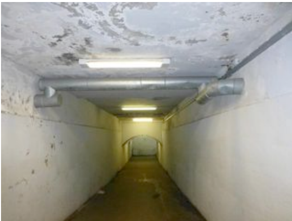
„Angstraum“ Unterführung zwischen den Bahnsteigen
