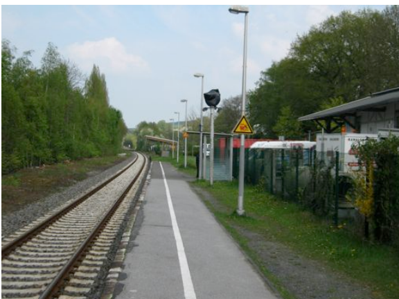
Der Bahnsteig und im Hintergrund ein Wetterschutz- häuschen – die Installation weiterer Anlagen wäre für die wartenden Fahrgäste wünschenswert
