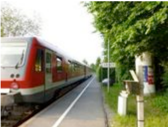
Der Bahnsteig ist verhältnismäßig schmal; der Einstieg in den Zug ist nicht barrierefrei
