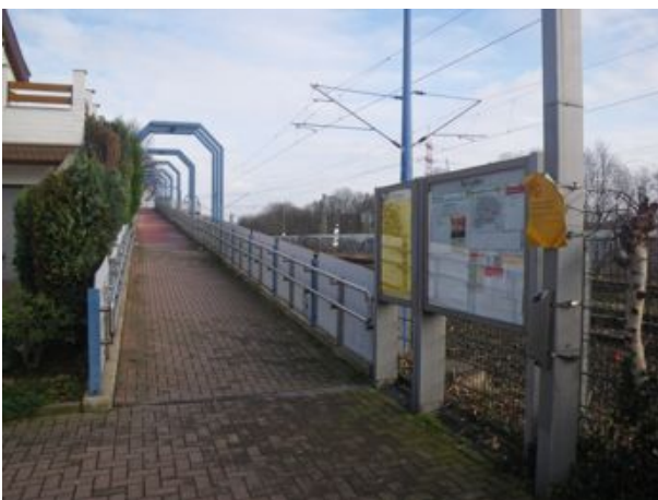
Barrierefreier östlicher Zugang, aber fehlender Fahrkartenautomat
