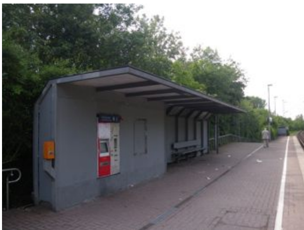
Fehlende Aushänge auf dem Bahnsteig
