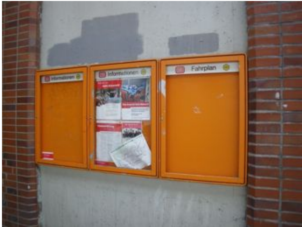
Fehlende Informationen und beschädigte Infokästen am Zugang
