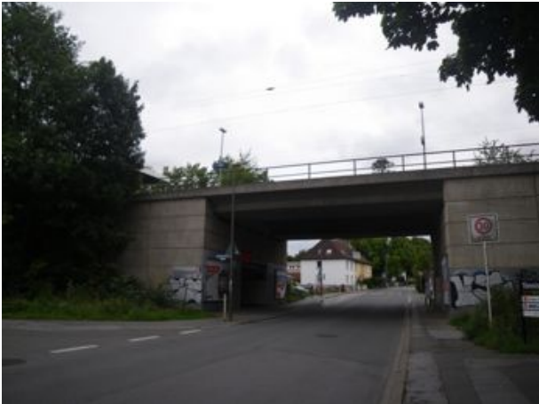
Schlecht von der Umgebung aus erkennbarer Bahnhof
