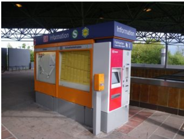
Gut auffindbare Informationen und Automaten, aber teilweise beschädigt/verschmiert
