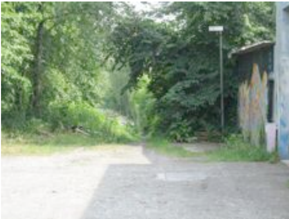
Trampelpfad als Hauptzugang zum Bahnsteig
