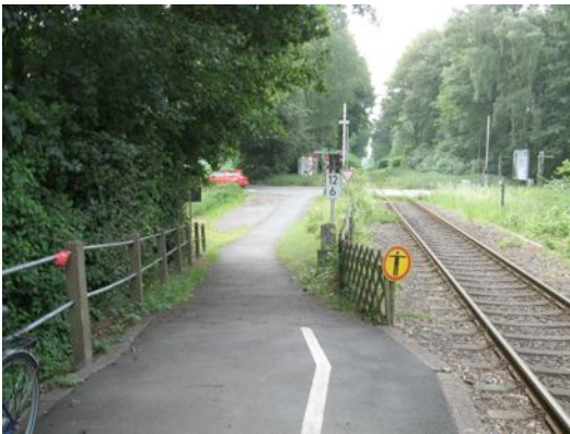
Der Bahnsteig befindet sich ca. 100 m zurückversetzt von der Straße
